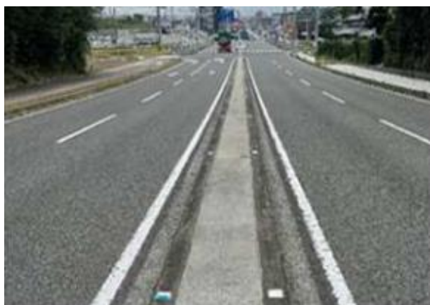
コンクリート舗装化（施工後3年時点）
